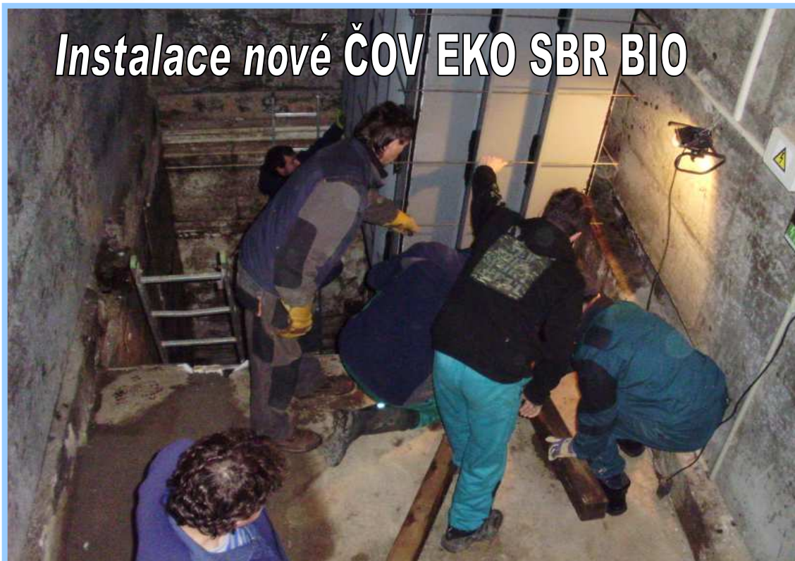
Instalace nové ČOV EKO SBR BIO
