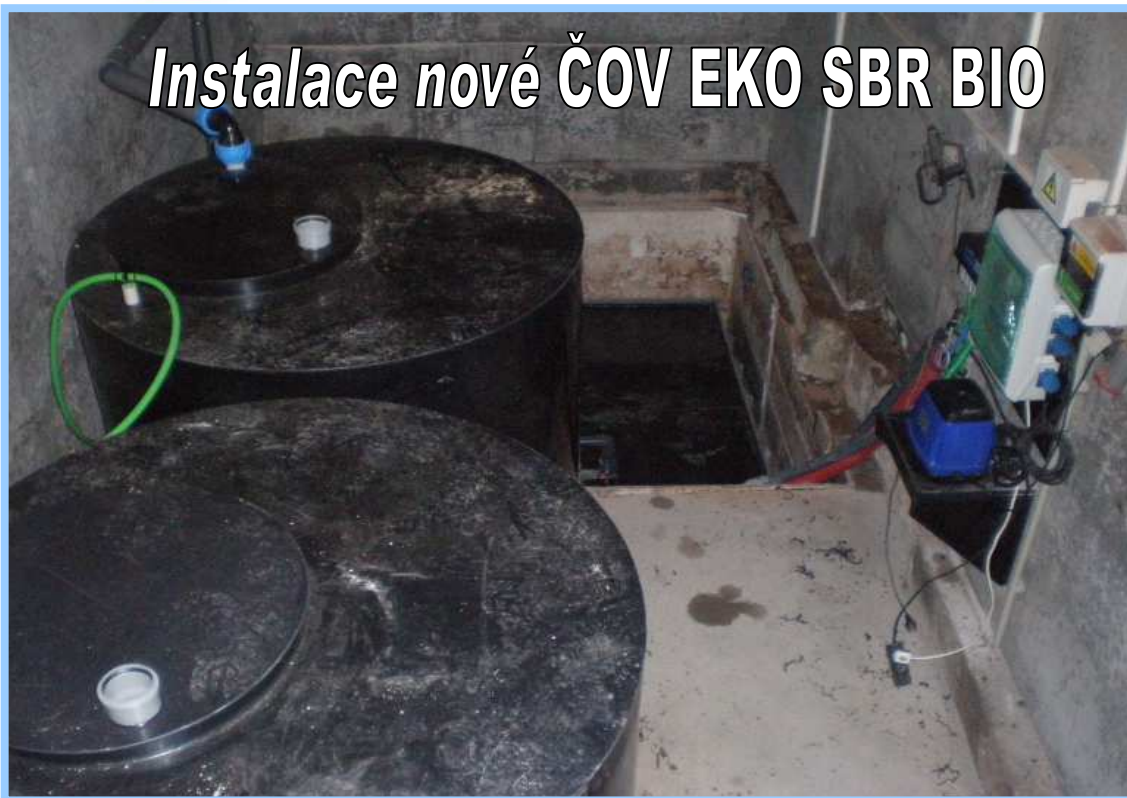
Instalace nové ČOV EKO SBR BIO
