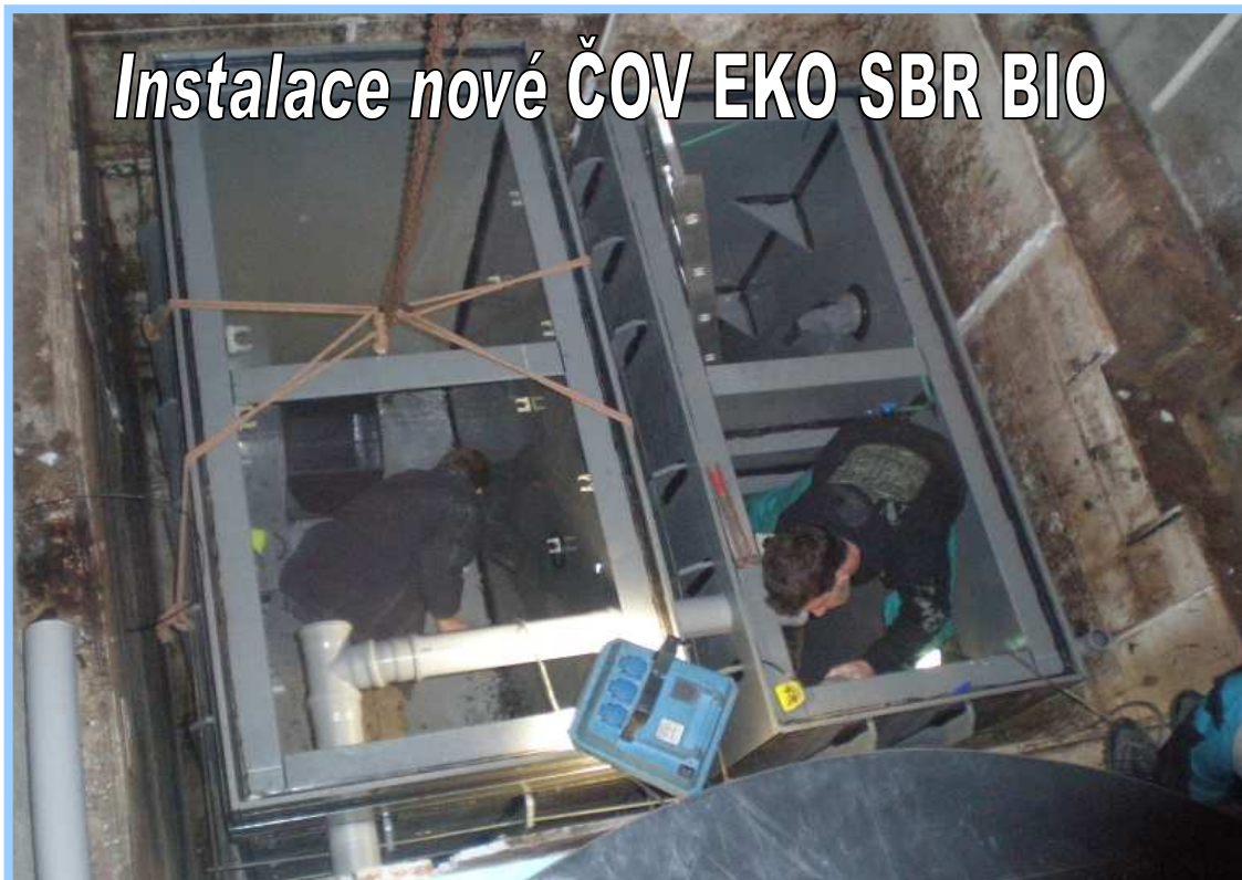
Instalace nové ČOV EKO SBR BIO
